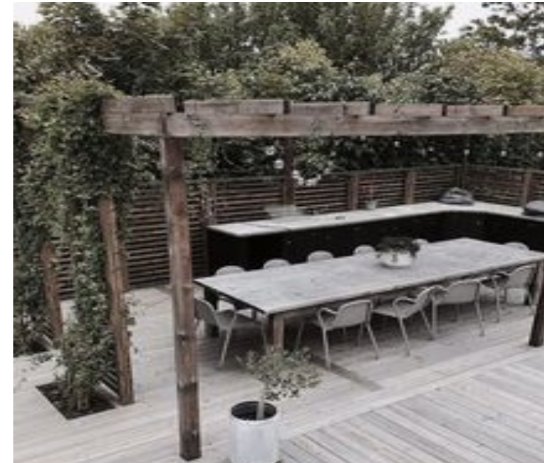
Platsbyggd pergola i tryckimpregnerat
